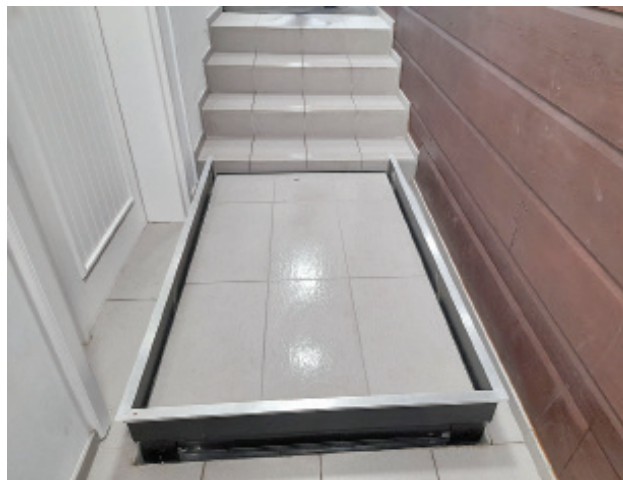
Winda schodowa wyłaniająca się z podłogi...
